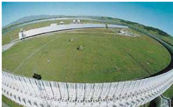
Радиотелескоп РАТАН-600 с кольцевой многоэлементной антенной переменного профиля диаметром 600 м — один из самых больших современных радиотелескопов — построен в Карачаево-Черкесии на высоте 970 м над уровнем моря. Изображение: «Наука и жизнь» с сайта http://elementy.ru
